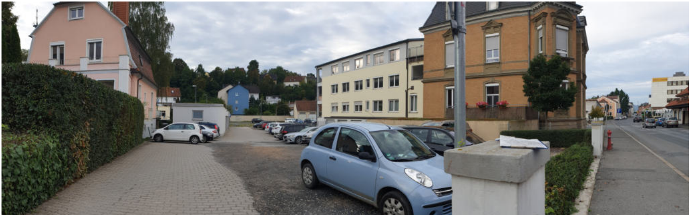
Abb. 112 Blick auf das Rahmenplangebiet Bamberger Straße (Foto: |u|m|s| STADTSTRATEGIEN)
