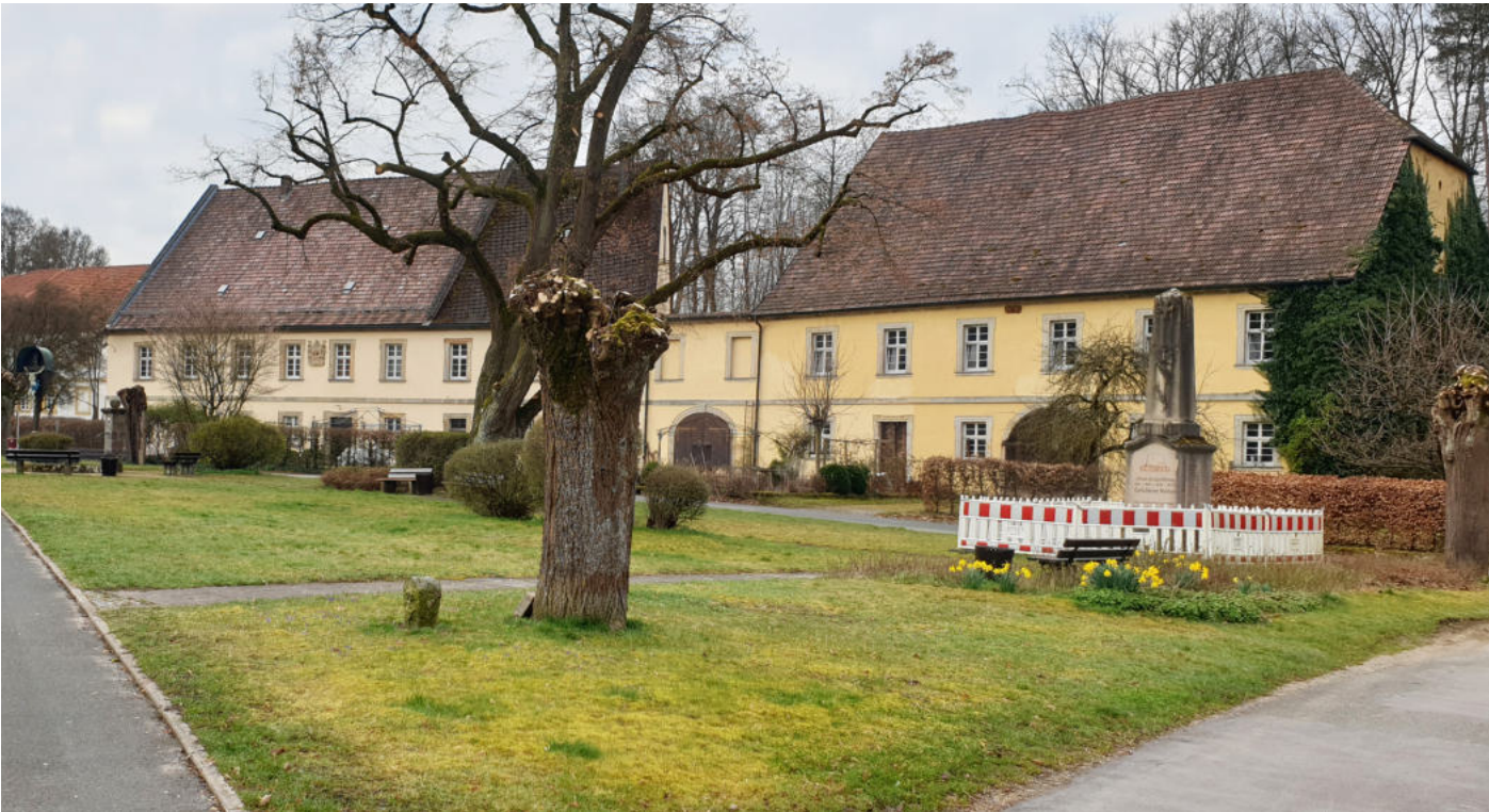
Blick auf Teile des ehemaligen Klostergeländes an der Hauptstrasse (© |u|m|s| STADTSTRATEGIEN)
