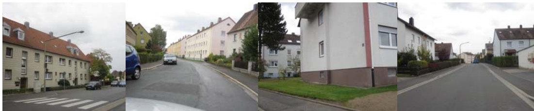
Energetischer Erneuerungsbedarf Quartier zwischen den Bahnlinien im Südosten
