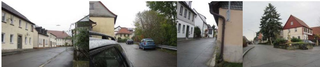
mangelhafte Straßen in Quartieren mit Mischnutzung entlang der Coburger Straße und in Oberwallenstadt
