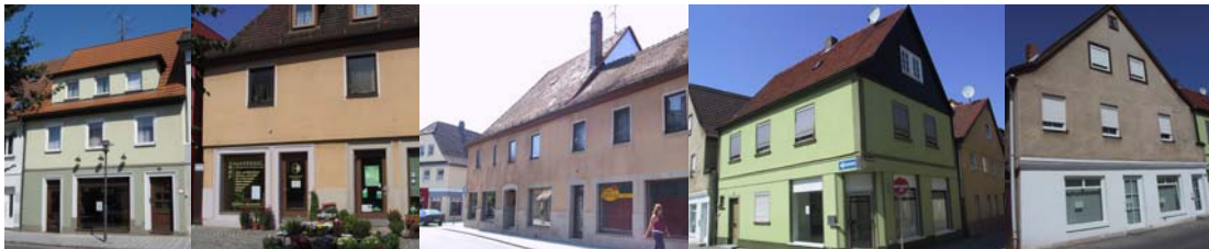
Teilleerstand in Hauptgebäuden: z.B. Coburger Straße 4, 9, 10, und Farbgasse 4, 6
