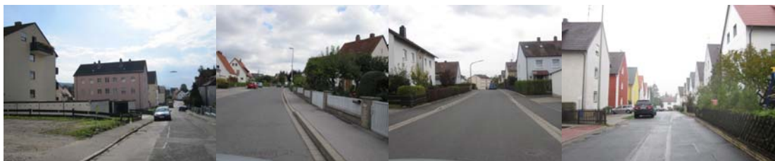
gestalterische Defizite im Straßenraum
