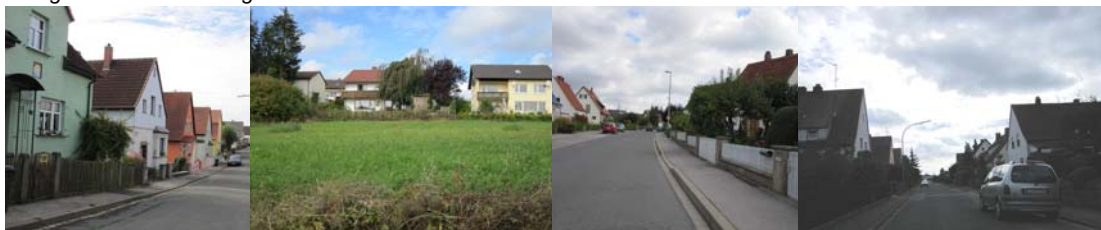
Energetischer Erneuerungsbedarf Im Wohnquartier zwischen Friedhofstraße und Zur Heide
