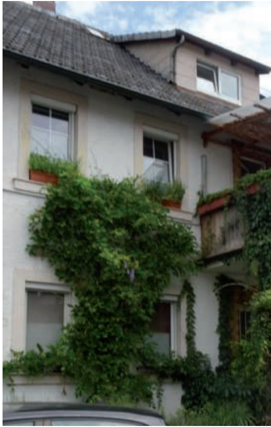
Abb. 93: Fassadengrün im Quartier Kleinau
