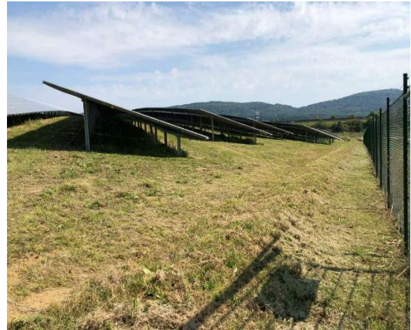
Abbildung 16: begrünte Verwallung zum Rückhalt von Oberflächenwasser nach Abschluss der Bau- maßnahme
