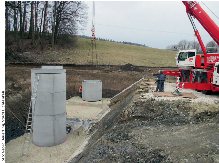
// Arbeiten zum Bau der Kleinkläranlage in Mönchkröttendorf.
