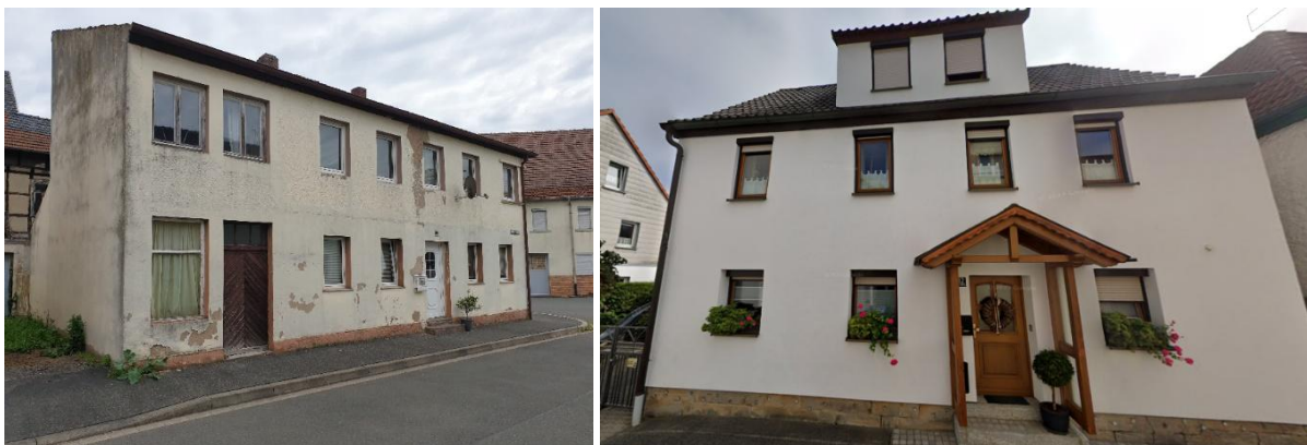
Abb. 21 Wohngebäude mit Sanierungspotenzial: Flößergasse 2 (li.) | Gebäude mit sanierter Fassade: Am Mühlbach 12 (re.) (Foto: |u|m|s| STADTSTRATEGIEN)
