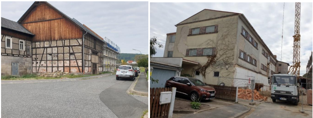
Abb. 23 Fachwerkscheune im Blockrand: Wassergasse 1 (li.) | Gebäude im Umbauprozess: Am Main 5 (re.) (Foto: |u|m|s| STADTSTRATEGIEN)
