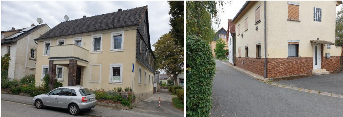
Abb. 22 Historisches freistehendes Wohngebäude mit Keramikfliesen, Schieferfassade und Ziegelsäulen: Schützengasse 2 (li.) | Fassade mit Keramikfliesen im Erdgeschoss: Mainwehrstraße 6 (re.) (Foto: |u|m|s| STADTSTRATEGIEN)
