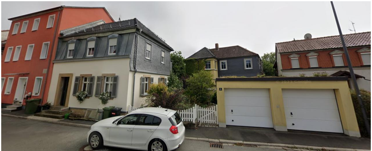
Abb. 12 Die Fischergasse 6 als Beispiel, wie eine wenig hochwertige Architektur in der unmittelbaren Nachbarschaft (hier insbesondere das Garagengebäude, aber auch das Hauptgebäude Nr. 10) negativ auf einen wertvollen Bestand einwirken kann (Foto: |u|m|s| STADTSTRATEGIEN)
