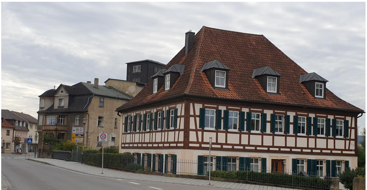
Abb. 16: Denkmalgeschütztes Eingangsgebäude an der Brücke in der südlichen Coburger Straße (Foto: |u|m|s| STADTSTRATEGIEN)
