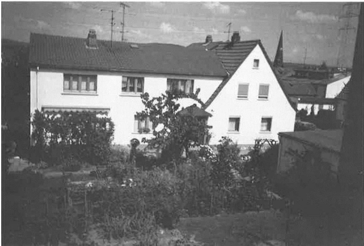
Abb. 6 Historisches Foto von einem typischen Siedlungshaus nach Aufstockung des Nebengebäudes bzw. Seitenflügels
