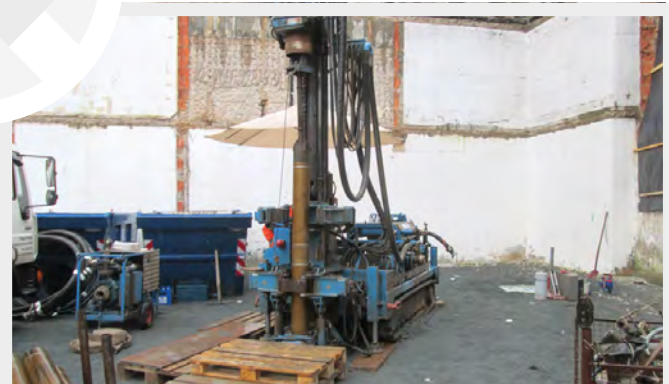
Geothermie-Bohrung Frühjahr 2022
