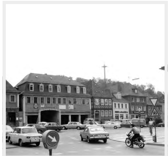
Umbauarbeiten Anfang der 1970er Jahre
