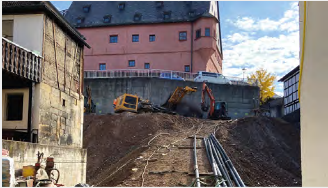
Auffüllung des Hofes für die Bohrung von Horizontalankern – Oktober 2022
